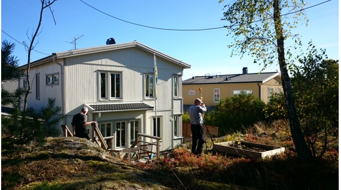
Bild 2. Sändarantenn på taket, typfall 2. I bildens övre del syns även matarkabeln till sändarantennen för typfall 5.
