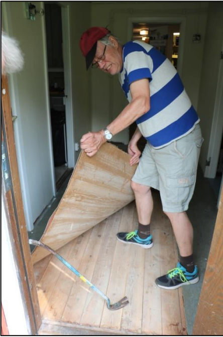
Golvläggning: 1 Slita bort gammal matta. 2 Ett furugolv visar sig. 3 Från vänster furugolv, foam, renoveringskiva
