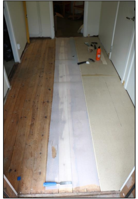
Golvläggning: 1 Slita bort gammal matta. 2 Ett furugolv visar sig. 3 Från vänster furugolv, foam, renoveringskiva
