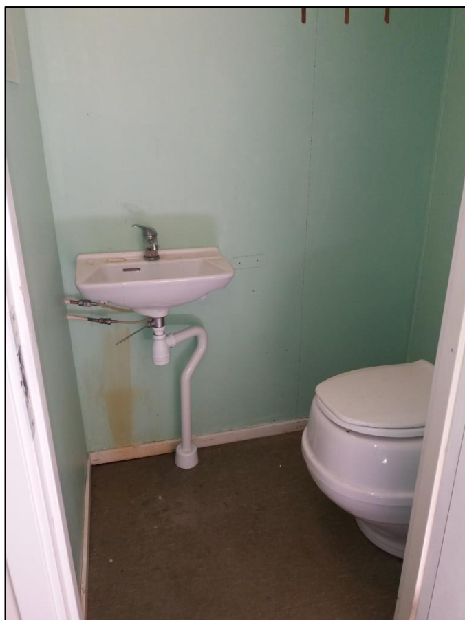
Toaletten före renovering.....
