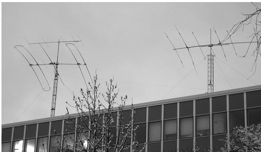
ITU-byggnaden i vinterskrud. Antennparken på taket med bl a StepIR som täcker 6-40 m
