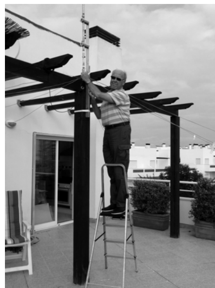
Justering av GP-antenn
