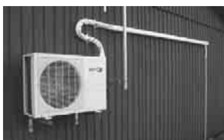
Bild nr 11: Till vår stora glädje installerade Joachim SMØWED vårt varmluftsaggregat innan vintern slog till. Därmed räddade han många sparade kronor till klubbkassan. - WED's hemma-QTH heter vad? 8 bokstäver.
